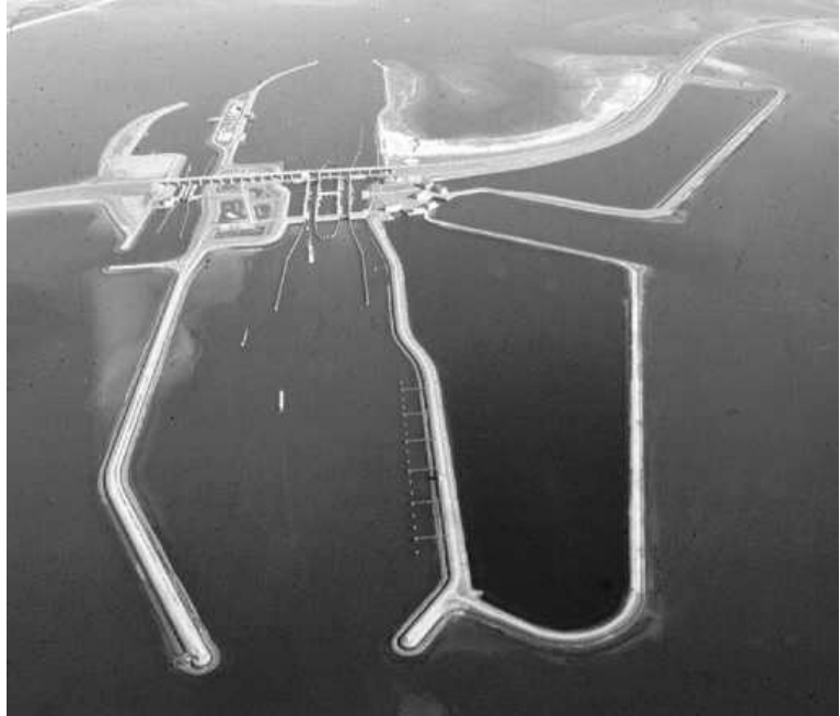
Figuur 10.6 Zout- zoetscheidingsluis in de Philipsdam.
