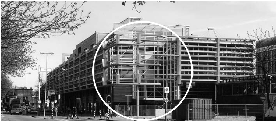
Figuur 20 De in de ruimte zwevende betonnen pui bij de entree (bron: Uytenhaak Architecten)
