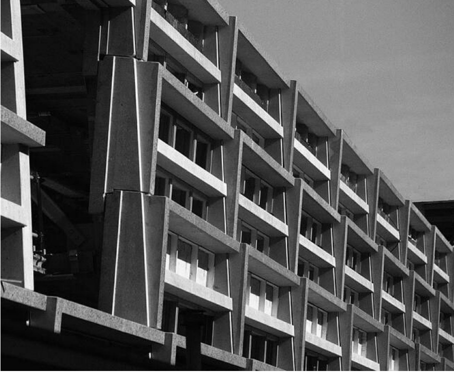
Figuur 24 Betonnen gevelelementen
