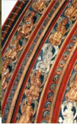
9. Bergportaal Sint-Servaaskerk te Maastricht. Restauratie Van Hoogevest en Satijn. 9. Berg portal Saint-Servaas' church in Maastricht. Restored by Van Hoogevest and Satijn.
