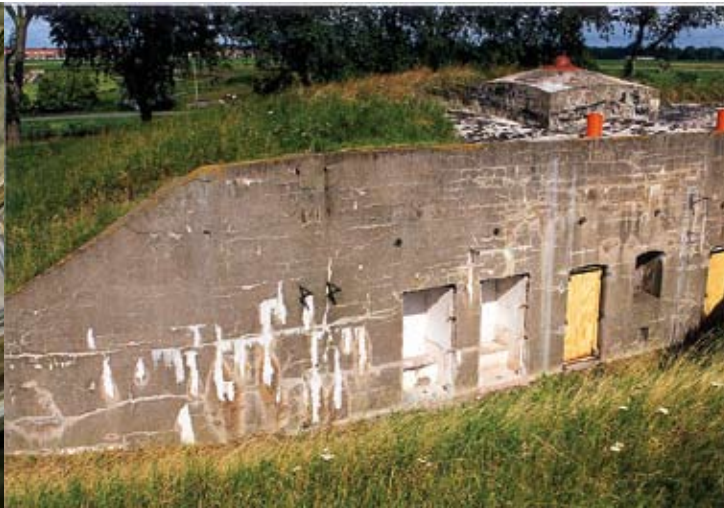
2. Betonnen fort (rond 1900) behorend tot de Stelling van Amsterdam, met vroege ASR 4 schade.
