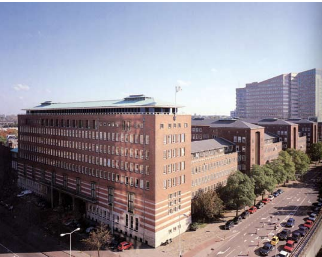
Ministerie van Landbouw, Natuurbeheer en Visserij (LNV) Oorspronkelijk van architect Gijsbert Friedhoff (Rijksbouwmeester), 1963 Ministry of Agriculture, Nature and Food Quality (LNV) Oorspronkelijk van architect Gijsbert Friedhoff (Chief Government Architect), 1963
